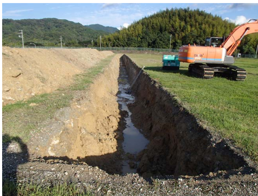
写真 5-2 トレンチ調査地点全景写真（トレンチ掘削後）
