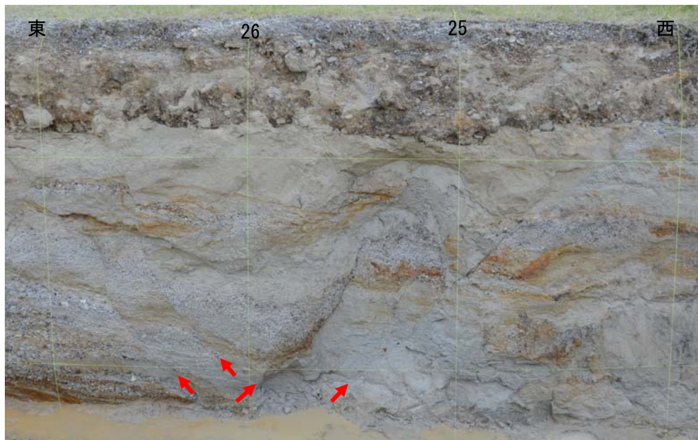
写真 5-3 測点 25-26m 付近の正断層 (赤矢印が断層位置)
