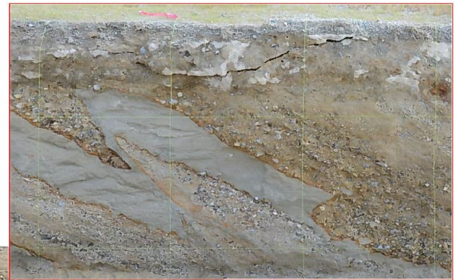
追加掘削前写真
