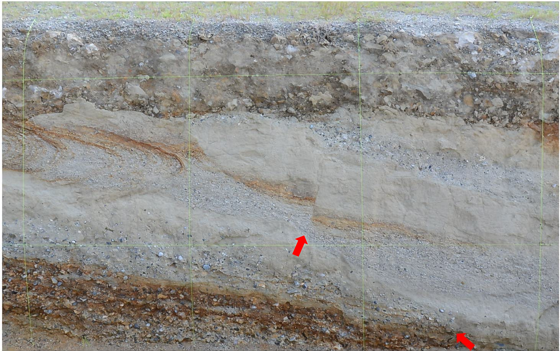
変位箇所拡大写真 測点62～63付近
